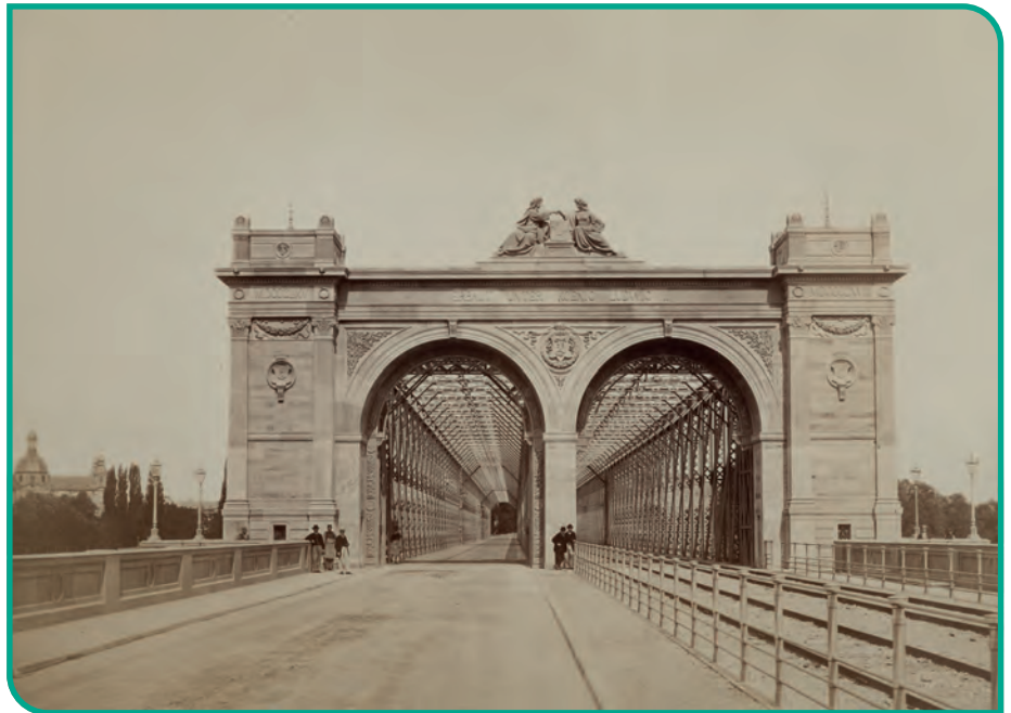
Josef Durm, Rheinbrücke zwischen Mannheim und Ludwigshafen, 1865–1868
