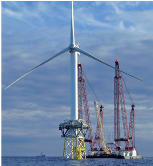
Abb. 8: Errichtung der Windenergieanlage REpower 5M im Beatrice-Field. (Quelle: REpower)
