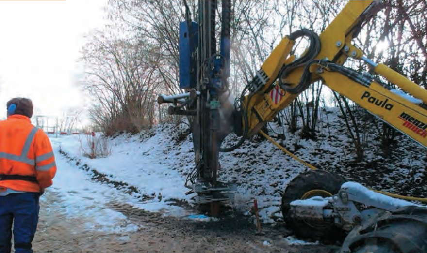
Abb. 4: Bohrarbeiten auf einer Altdeponie (© Honorarprofessor Dr. Tidden, BAUER Resources GmbH)
