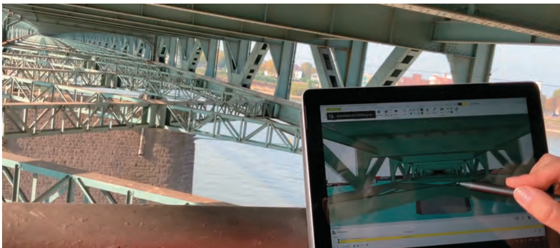
Einsatz des BIM-Mobils bei der Bauwerksprüfung und -instandhaltung
