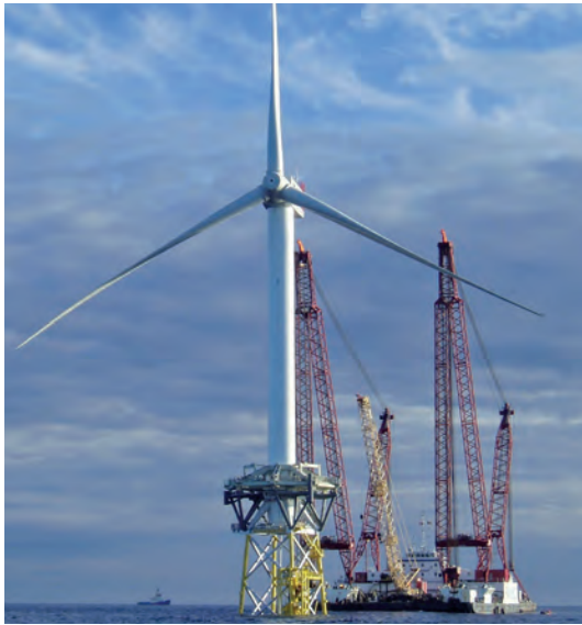
Abb. 8: Errichtung der Windenergieanlage REpower 5M im Beatrice-Field. Quelle: REpower
