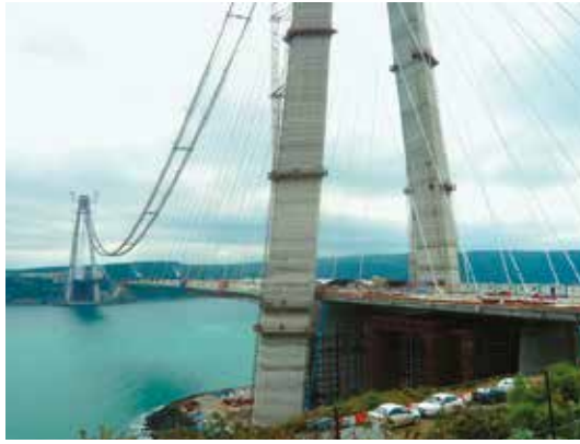
Abb. 6: Dritte Bosphorusbrücke (Yavuz-Sultan-Selim-Brücke) im Bauzustand (Foto: Thomas Freimann)
