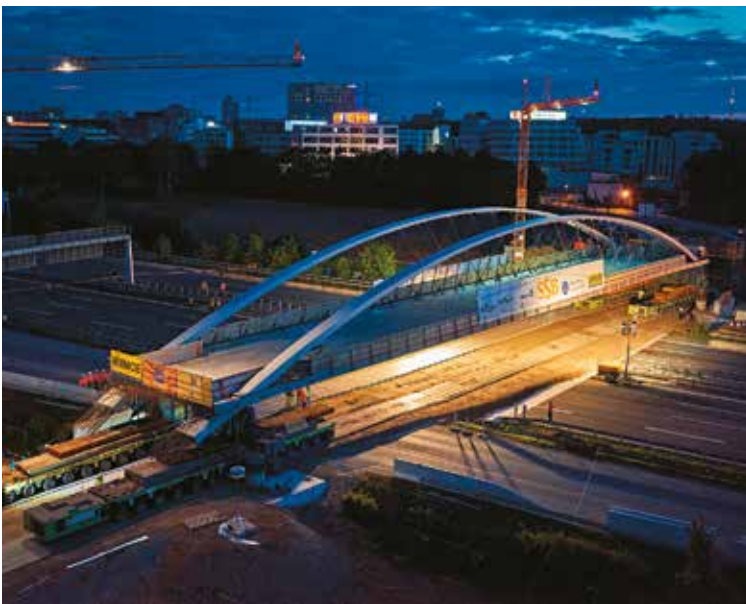
Stadtbahnbrücke über die A8
