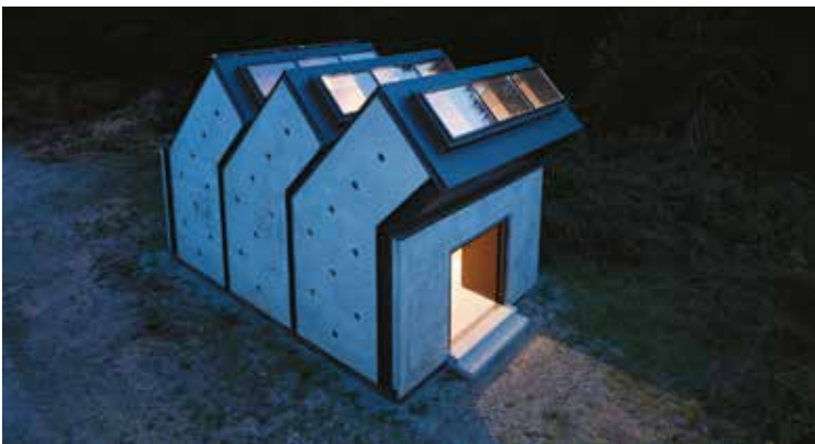
Abb. 1: Die Siedlung begehrter, innovativer Musterbauten in Betonbauweise auf dem Campus der RPTU in Kaiserslautern dient der praktischen Umsetzung und Validierung von Forschungsergebnissen. Foto: Sven Paustian, Port25
