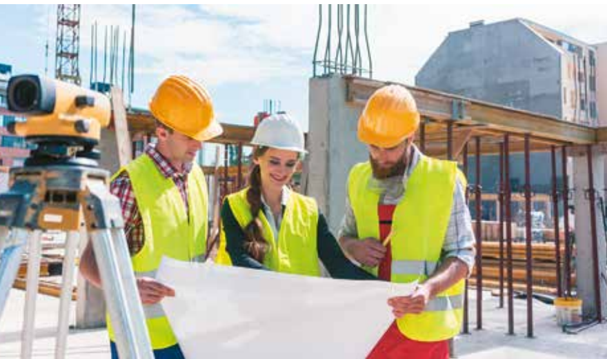
Angehenden Bauingenieur:innen stehen alle Wege offen. (shutterstock 1817376860)
