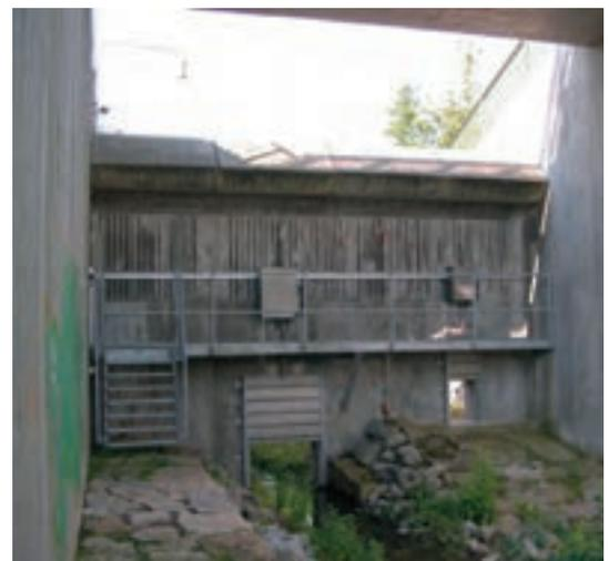
Abb. 1: Betriebsauslass und Hochwasserentlastung eines Hochwasserrückhaltebeckens. (Bildquelle: Jürgen Ihringer, KIT)
