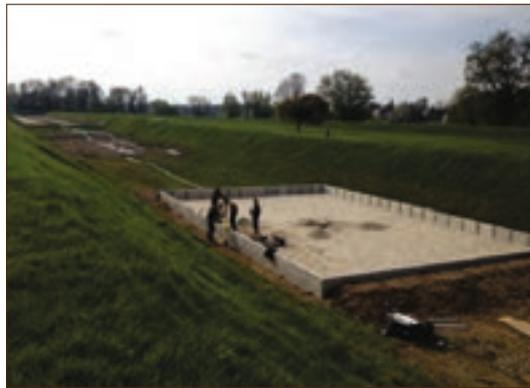
Abb. 2: Installation von Messtechnik im Sickerschlitzen und Versickerungsbecken im Wasserwerk Dresden-Hosterwitz
