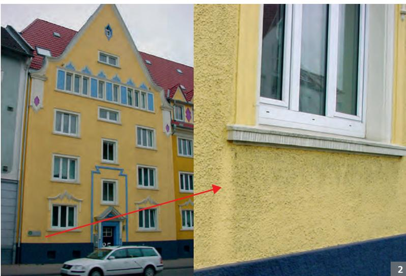
Abb. 2: Fassade, die mit einer fotokatalytisch „arbeitenden“ Beschichtung versehen wurde, die zu einer Selbstreinigung führen sollte.
