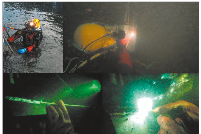
Abbildung 1: Nasses Unterswasserschweißen mit umhüllter Elektrode
